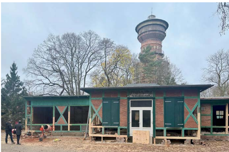
Bei der umfangreichen Sanierung sind auch Arbeiten am Fundament der historischen Trinkhalle erforderlich, denn das ursprüngliche Gebäude wurde 1884 „auf Sand gebaut“.
