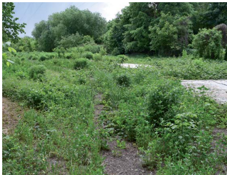
Von den einstigen Gärten, deren Lauben die Tamax bereits abreißen ließ, sind noch zahlreiche Fundamente sowie immer mehr Wildwuchs zu sehen.
