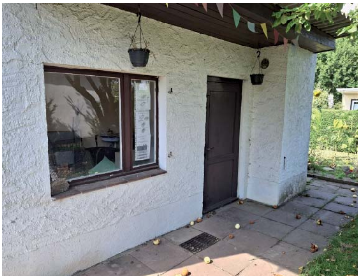
Die künftige Vereinslaube soll den Schülern Zuflucht bei schlechtem Wetter gewähren und zudem mit einer Schultafel ausgestattet werden. Fotos: J. Barz (1), KGV
