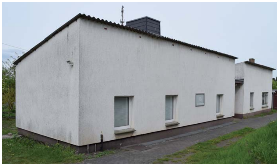
Im Zuge der Vorbereitung auf die Landesgartenschau 2027 in Wittenberge soll auch die Geschäftsstelle des Kreisverbandes Prignitz modernisiert werden.
